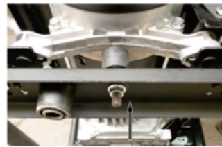
擰緊支架下面的螺栓, 固定位置
